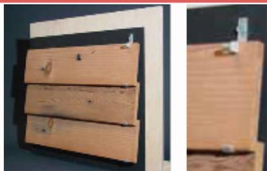
Ce système bien qu'efficace, n'a pas été choisi pour l'école car même si l'espacement entre et derrière les lames permet une bonne ventilation, il réduit également la résistance au feu du bâtiment qui est situé dans une zone à risque élevé.
