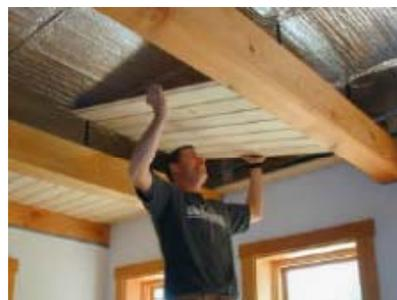
L'avantage d'avoir les différents réseaux apparents et non dépendants d'une structure est de faciliter le démontage du bâtiment. De plus, ces panneaux peuvent être facilement enlevés et récupérés.
