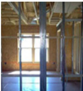
**5. Cloisons sans plomberie :** composées d'une ossature métallique recouverte de plaques de plâtre pouvant être déplacées ou supprimées individuellement. Les vis sont laissés visibles pour faciliter le démontage.
