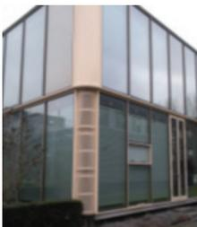
**Façades :** indépendantes de la structure, des consoles en acier connectent les modules en verre préassemblés (2x5m) à la structure
