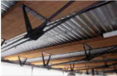
L'utilisation de matériaux de récupération faisait partie d'une stratégie plus large de conception écologique. Des poutres récupérées en lamellé collé ont été obtenues directement depuis la déconstruction d'un bâtiment existant. Pour servir de structure au toit, les poutres ont été renforcées par des câbles en acier mis sous tension.
